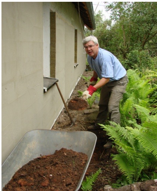
Schweißtreibend: Erweiterung des Lichtschachts
